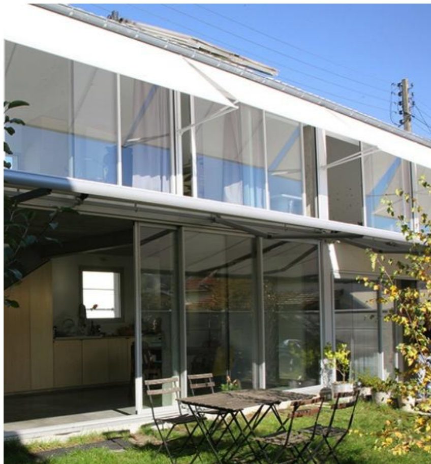
Menuiseries extérieures Aluminium + Occultation solaire extérieure de type Store au Sud
