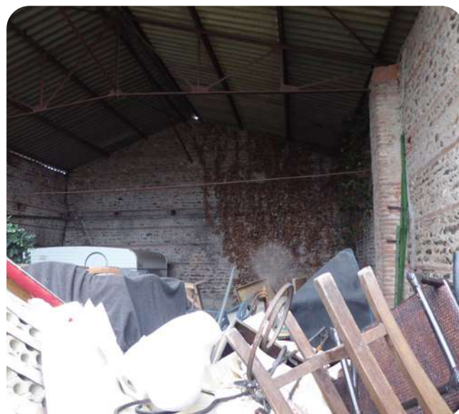
Espace intérieur encombré
