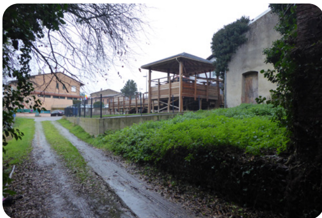
Vue sur le chemin longeant le ruisseau
