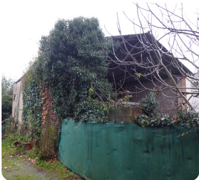
Façades Nord et Est
