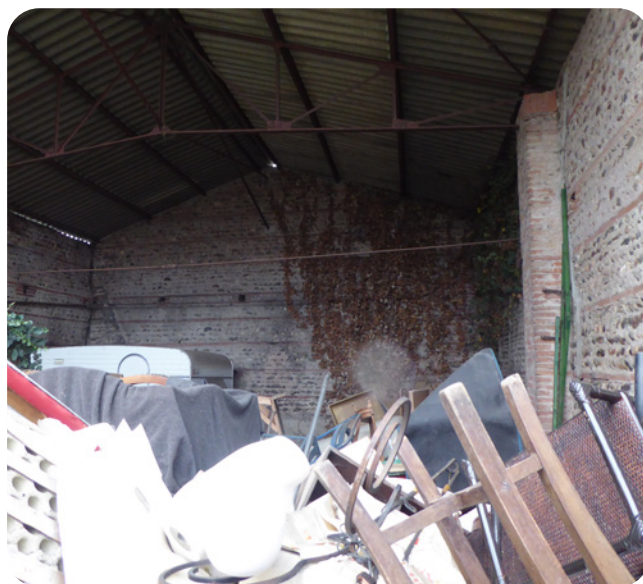
Espace intérieur encombré
